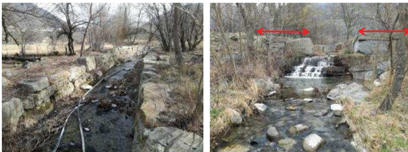
Foto 17: Tratto terminale rio Cassarot oggetto di rifacimento con abbassamento del fondo (a sinistra) e porzioni dell'argine del torrente Pellice da ripristinare in seguito al rifacimento della confluenza (a destra).
