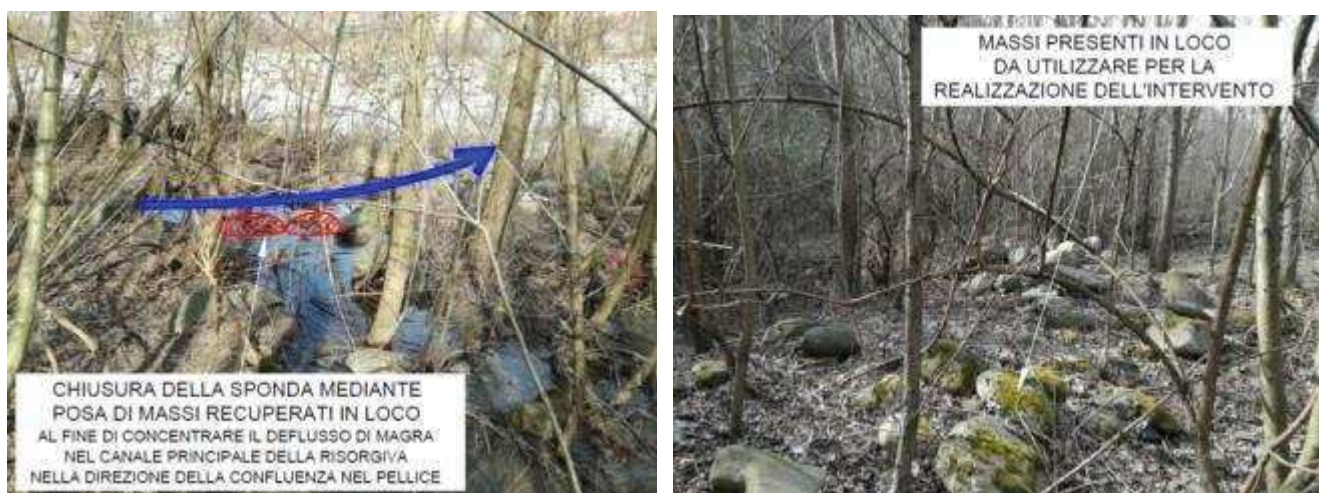
Foto 25: Vista del tratto in cui è prevista la posa di massi d'alveo a chiusura della sponda destra della risorgiva (a sinistra), facilmente reperibili in loco (a destra).
