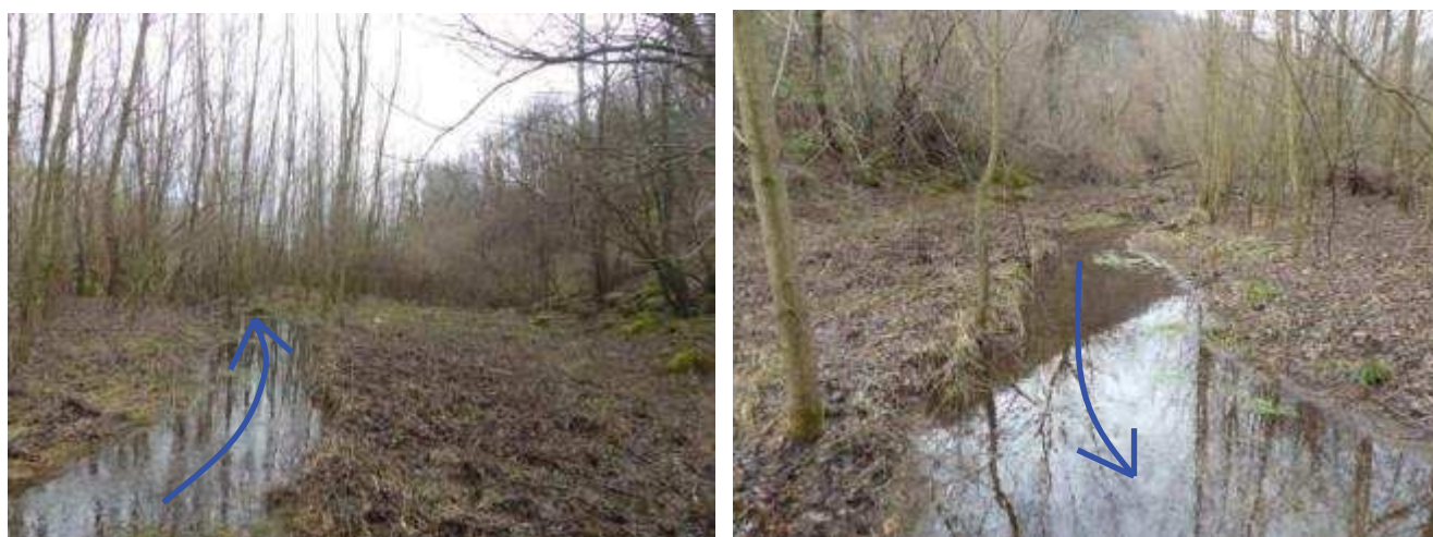
Foto 26: Vista della risorgiva nel tratto interessato dalla realizzazione di due aree di riproduzione della fauna ittica (INTERVENTO A.2).
