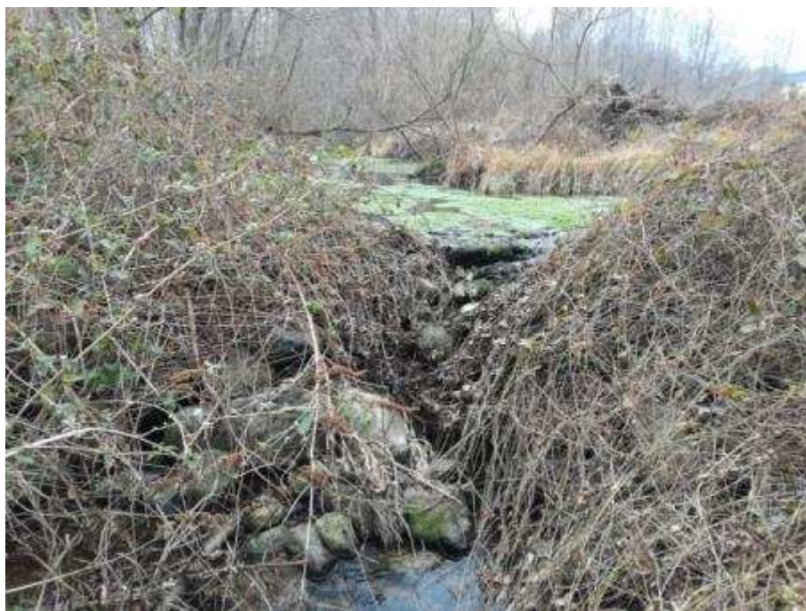
Foto 15: Vista da valle del salto di fondo intermedio connesso ad un guado a servizio di una pista di accesso all'alveo del torrente Pellice.
