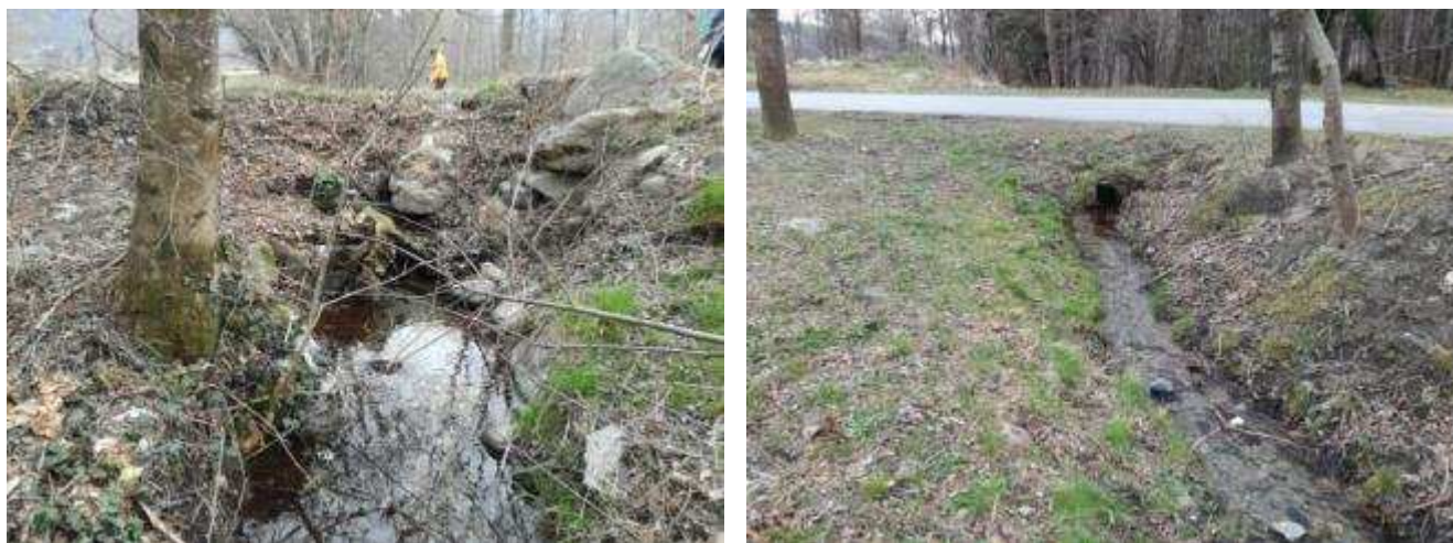
Foto 23: Sottopasso stradale della risorgiva mediante condotta in calcestruzzo, visto da valle (a sinistra) e da monte (a destra).
