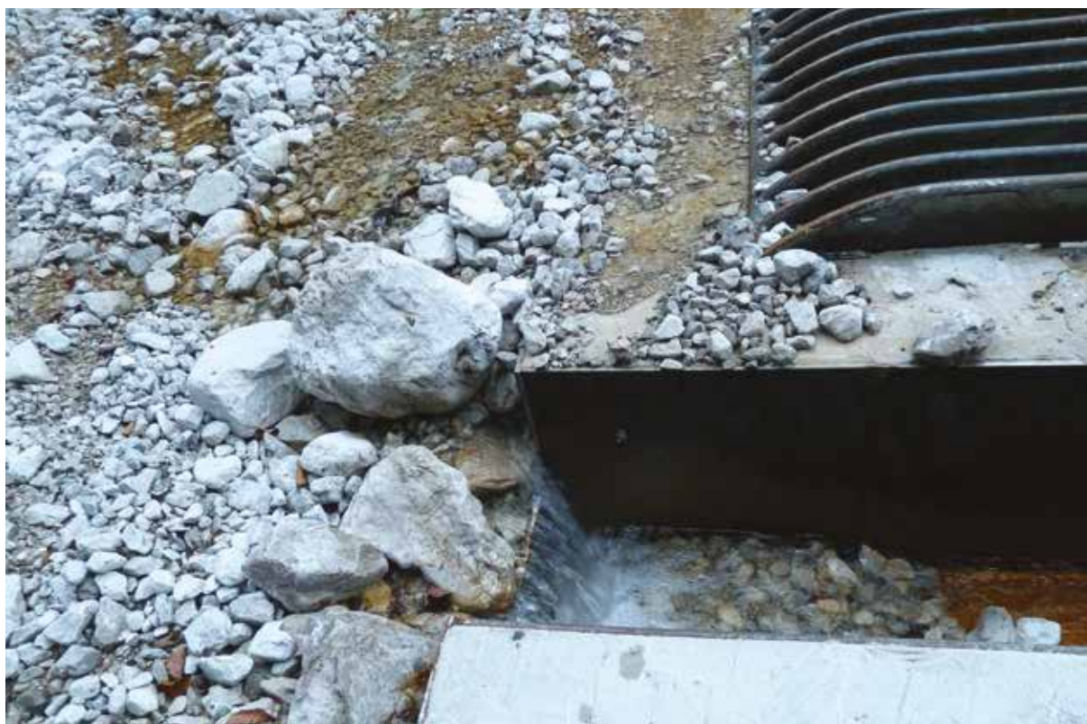
Figura 15: presa impianto Valmontina
