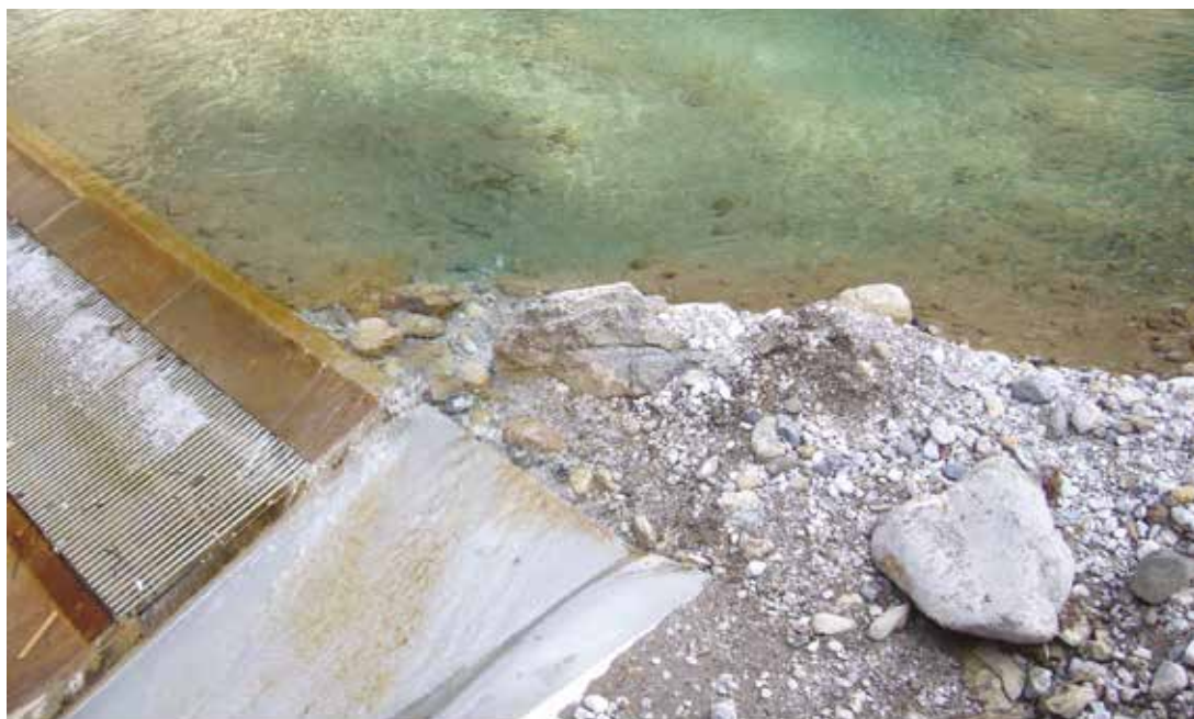
Figura 13: presa impianto EN Piova (Comune di Vigo in società con En & En), 2012
