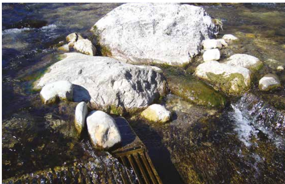
Figura 14: presa impianto torrente Maè, Zoldo Energy, 2012
