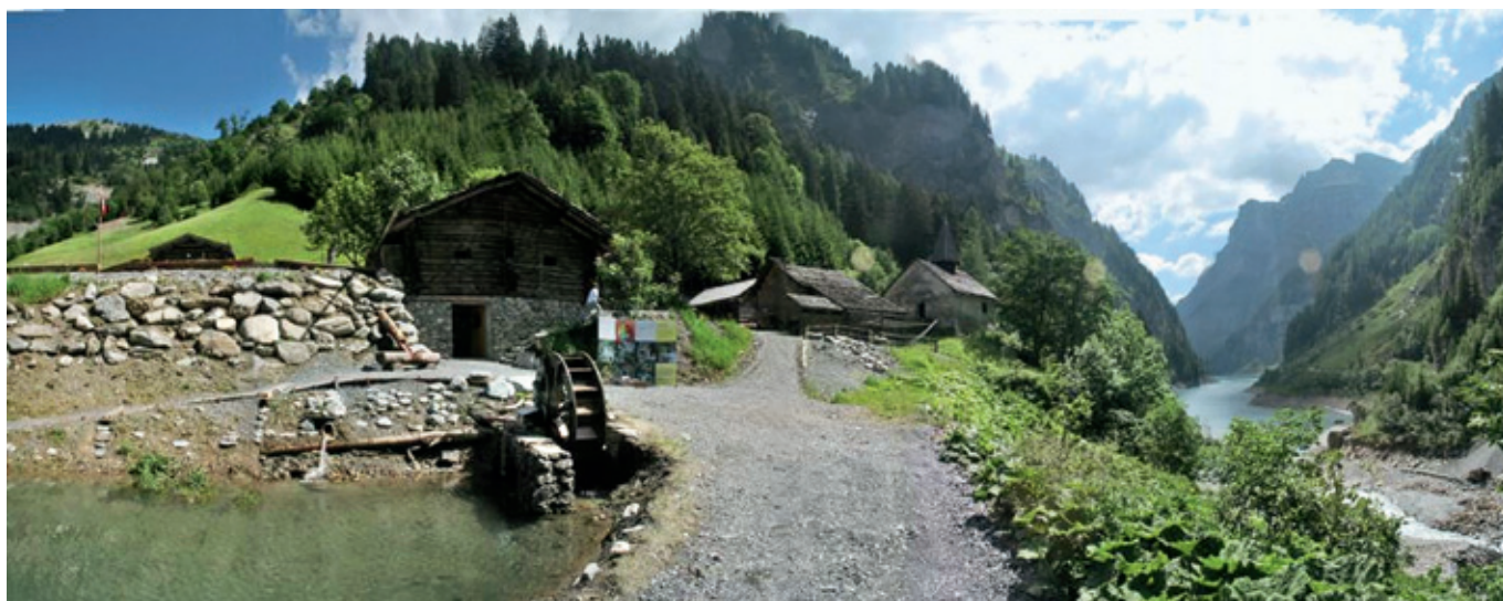
Figura 5: St. Martin, un insediamento nelle Alpi (Cantone dei Grigioni, Svizzera) senza collegamento alla rete elettrica pubblica. L'elettricità viene prodotta da una piccola centrale idroelettrica. © Programma piccole centrali idrauliche 16
