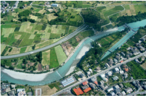
Centrale idroelettrica con derivazione d'acqua 11
