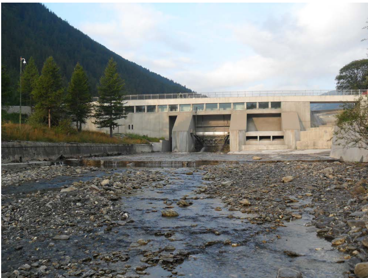
22 agosto 2011 – Il Chisone a valle della diga di Pourrières
